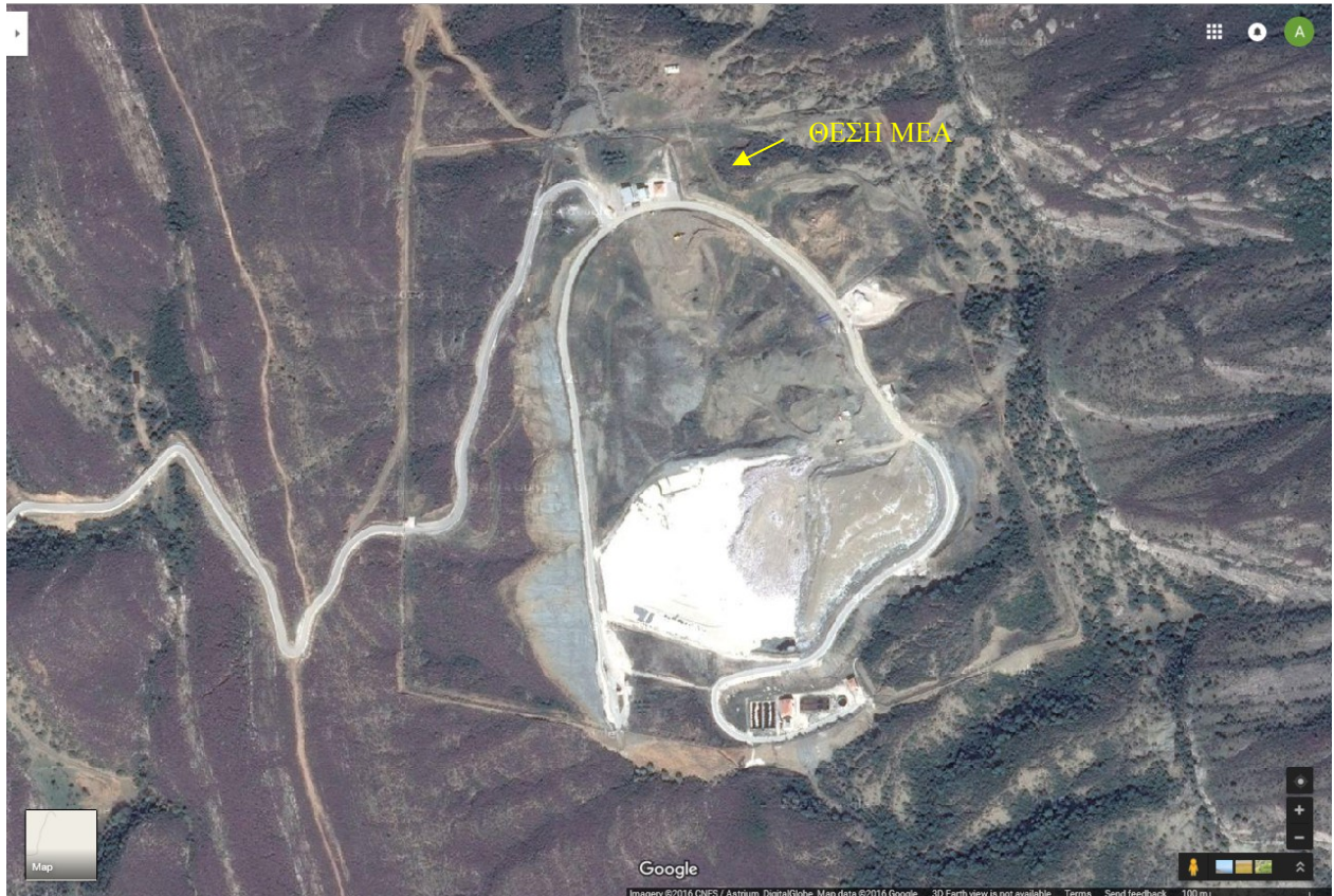
Φωτο 1.1 Αεροφωτογραφία του ΧΥΤΑ 2 ης Δ.Ε.Ν. Αιτ'νίας. Με κίτρινο χρώμα επισημαίνεται η θέση της Μονάδας Επεξεργασίας Απορριμμάτων (ΜΕΑ).
