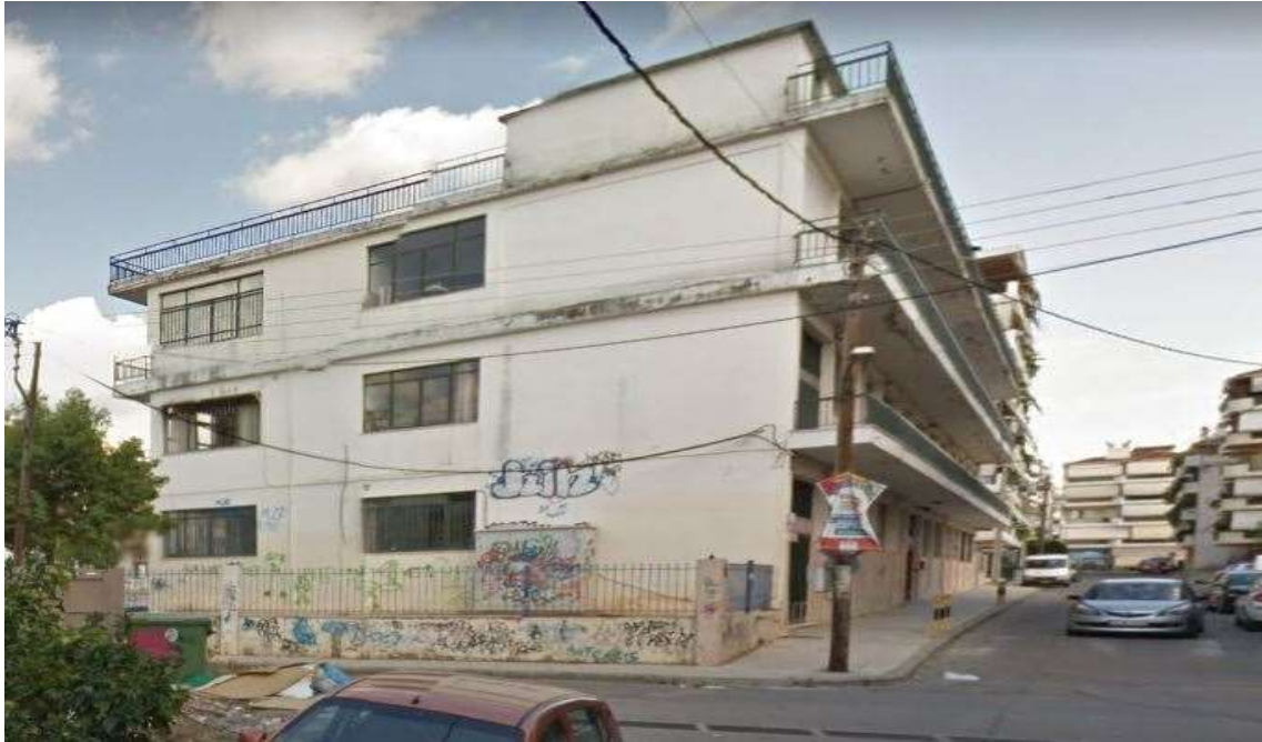
Εικόνα 2 : 11° & 17ο Δημοτικό Σχολείο και 11ου Νηπιαγωγείο Δυτική όψη.
