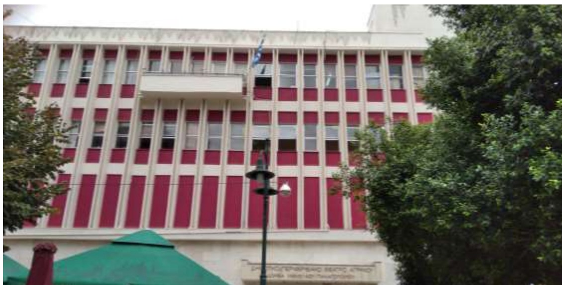
Εικόνα 3 : Δημαρχείο Αγρινίου Νότια Όψη
