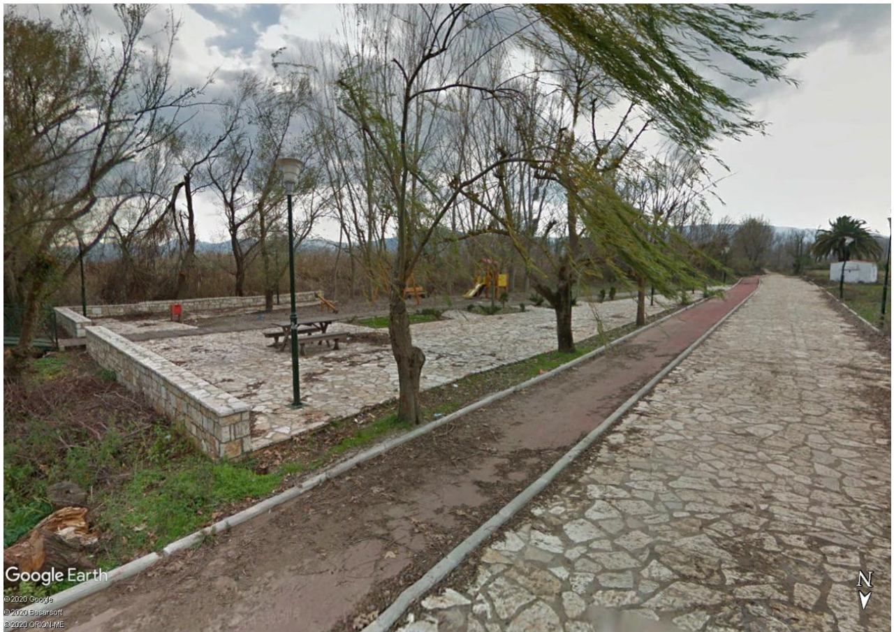
Εικόνα 3. Τμήμα του πλακοστρωμένου χώρου αναψυχής δίπλα από την Παιδική Χαρά με τον πλευρικό ποδηλατόδρομο και την πλακοστρωμένη οδό
