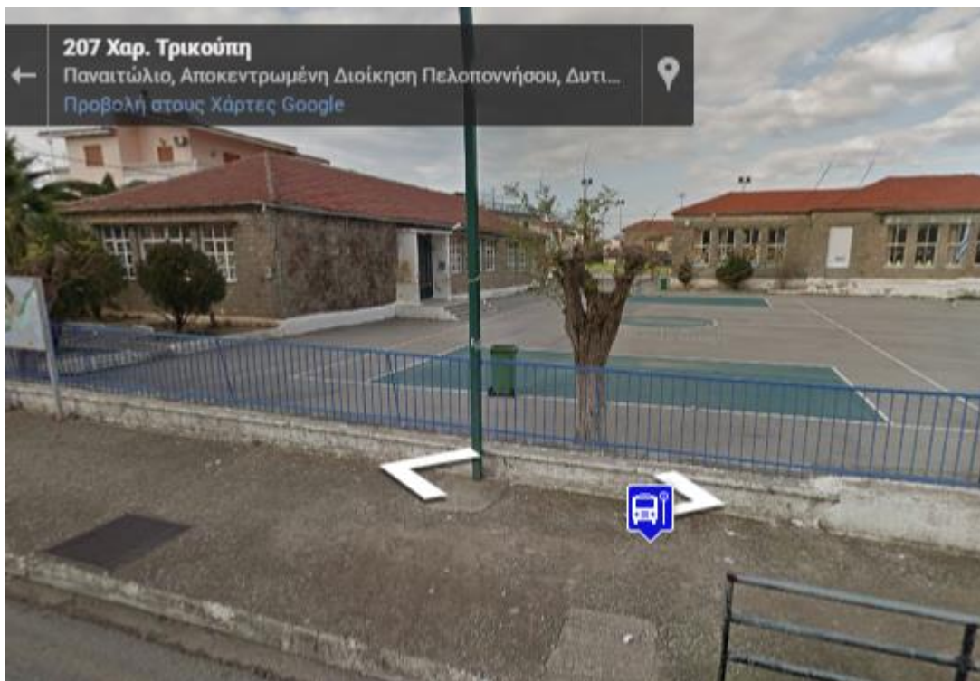
Εικόνα 18 - Στάση Δημοτικό Σχολείο Παναιτωλίου
