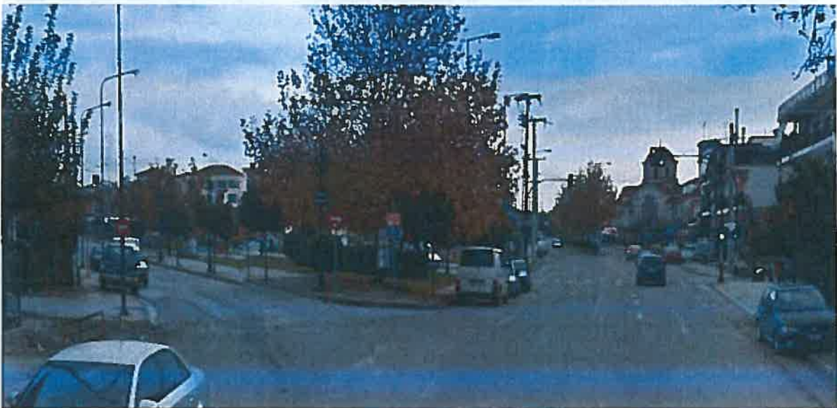
Φωτογραφία 4: Άποψη του υφιστάμενου κόμβου (οδοί Εθ. Αντιστάσεως - Καρπενησίου)
