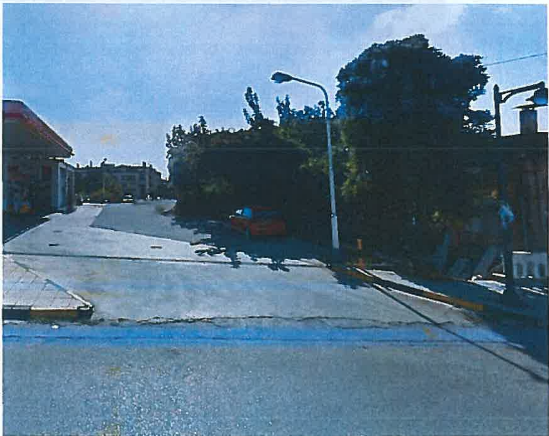
Φωτογραφία 4: Διάνοιξη οδού Αλεξιά (σύνδεση με Εθνικής Αντιστάσεως)
