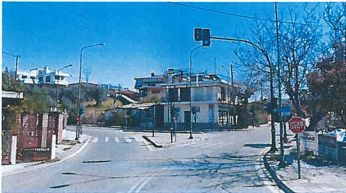
Φωτογραφία 6: Άποψη του κόμβου οδών Γ. Παπανδρέου – Καρπενησίου, που βρίσκεται πλησίον του εξεταζόμενου κόμβου
