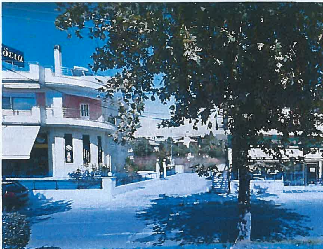
Φωτογραφία 7: οδός μεταξύ των Ο.Τ. Κ1194 – Κ1192 (πεζόδρομος)
