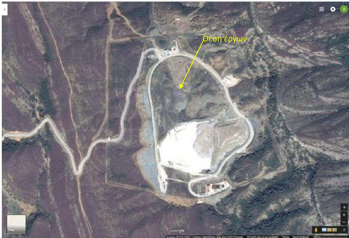
Εικόνα 1: Αεροφωτογραφία του ΧΥΤΑ 2ης Δ.Ε.Ν. Αιτ/νίας. Με κίτρινο χρώμα επισημαίνεται η θέση των έργων επέκτασης.
