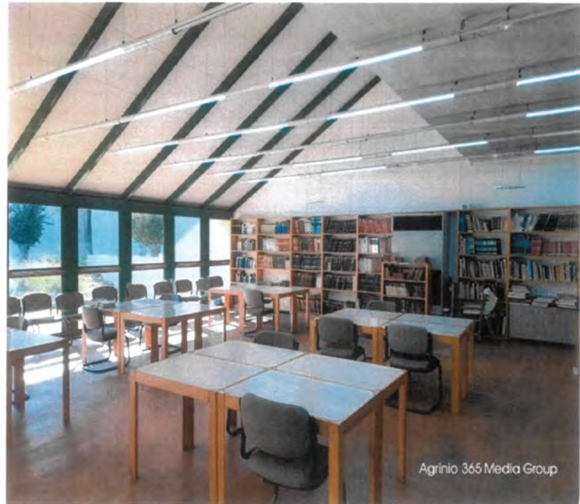
ΤΥΠΟΣ 1 : Φωτιστικά οροφής με λαμπτήρες τεχνολογίας led 58Watt
