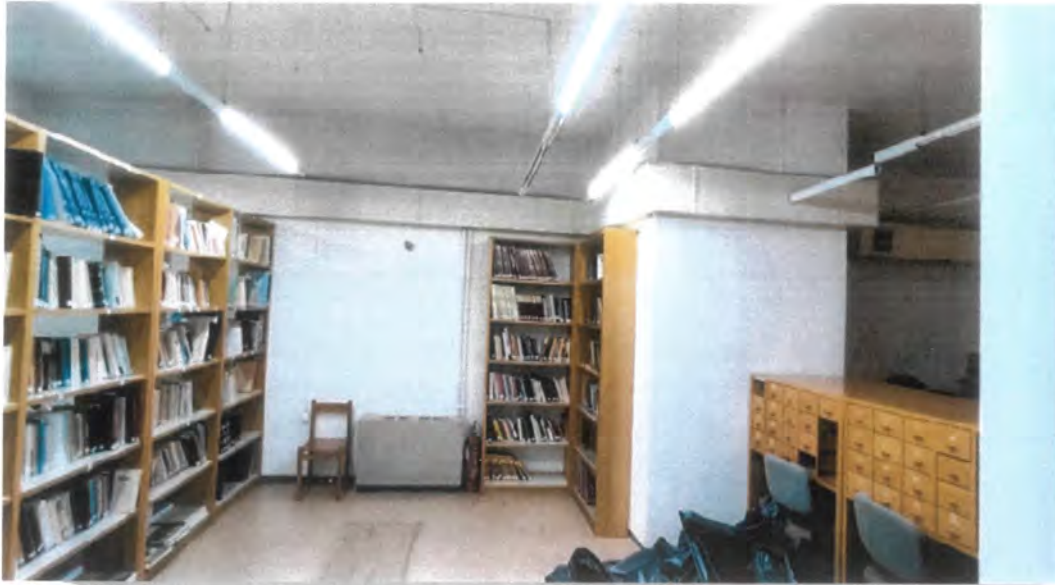
ΤΥΠΟΣ 2 : Φωτιστικά οροφής γραμμικού φθορισμού 29Watt
