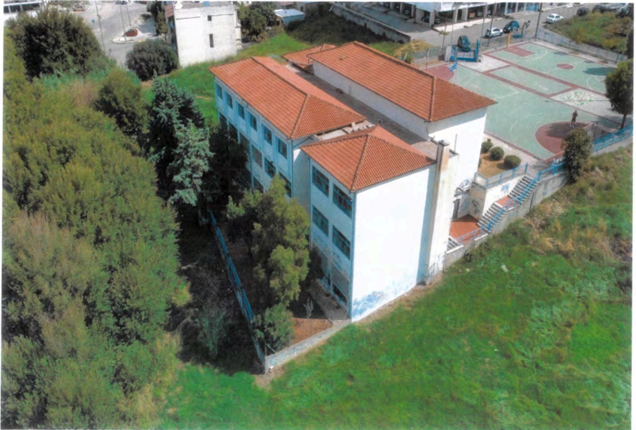
Εικόνα 5: Νότια Όψη Κτιρίου
