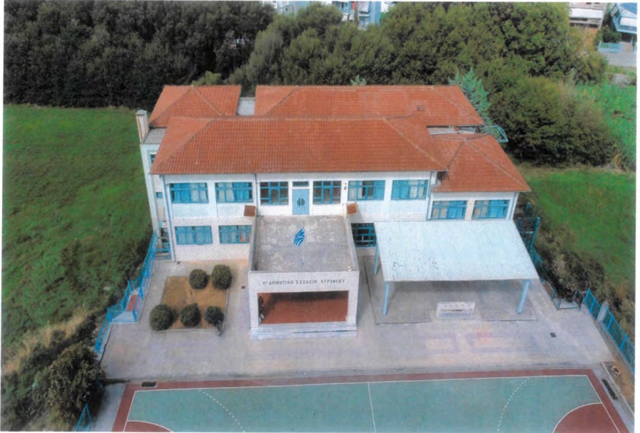
Εικόνα 4: Δυτική Όψη Κτιρίου
